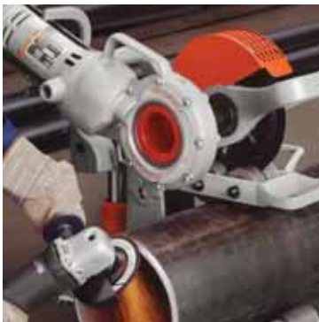
Modelo 258 con rodillo de tubos durante el biselado. Se recomiendan dos operarios para esta tarea.
